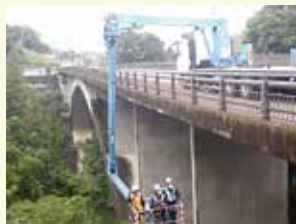
橋の点検の様子
