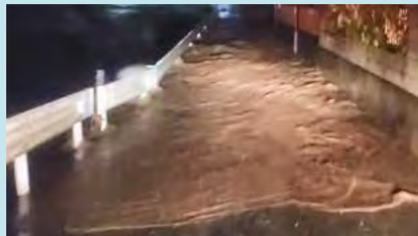
風戸橋付近の境川が氾濫している様子
