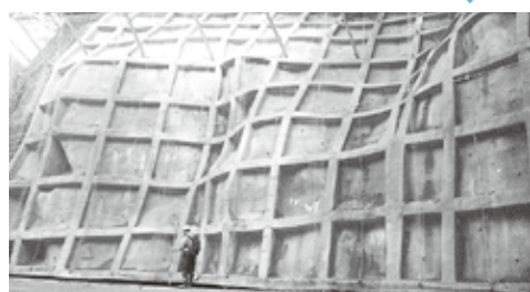
モルタルを吹き付けて固めます
