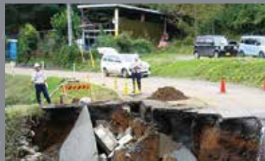
職員による現地調査
