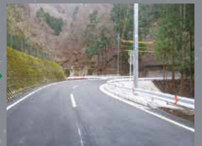
盛土工事により本復旧完了
