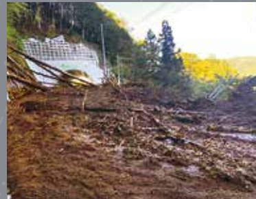
道路沿いの斜面から土砂や倒木が流出
