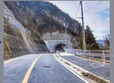
法面をコンクリートで覆い本復旧完了
