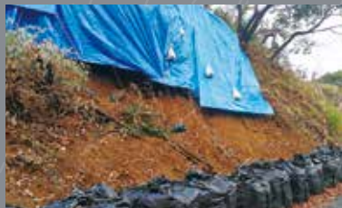
大型土のうやブルーシートによる応急復旧
