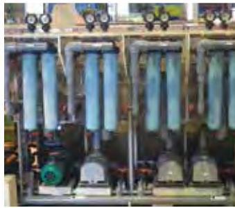
相模原工場の製造ラインの一部
