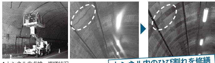
▲トンネルの点検・修繕状況
