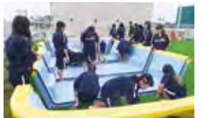
プールの解体作業の様子
