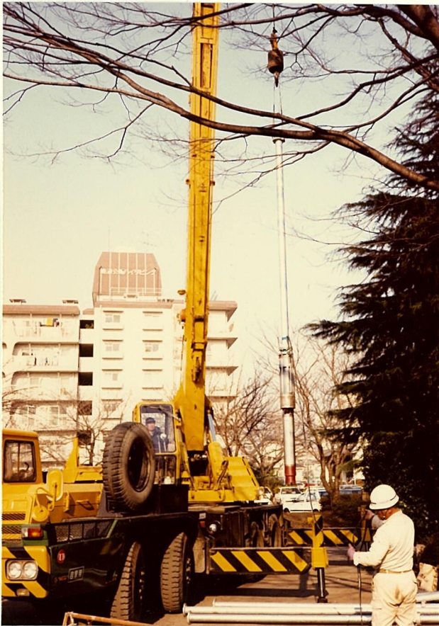
水中ポンプ挿入状況
