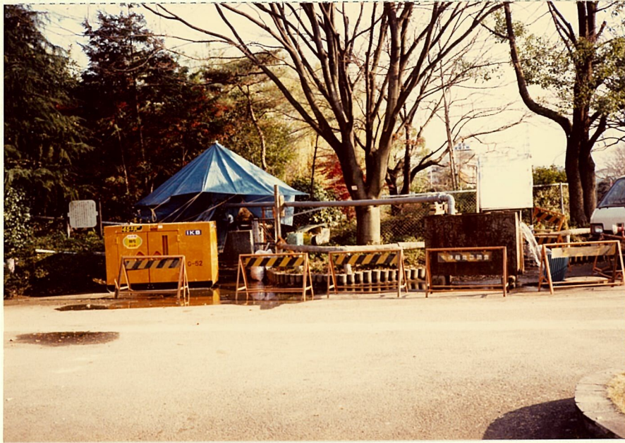
揚水試験装置全景
