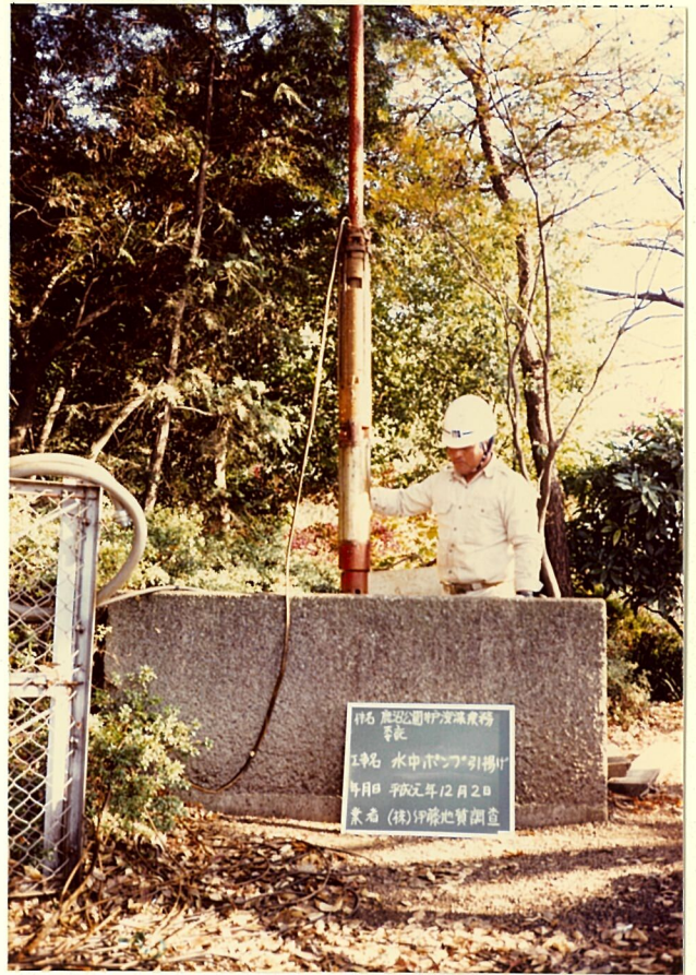
水中ポンプ引揚状況
