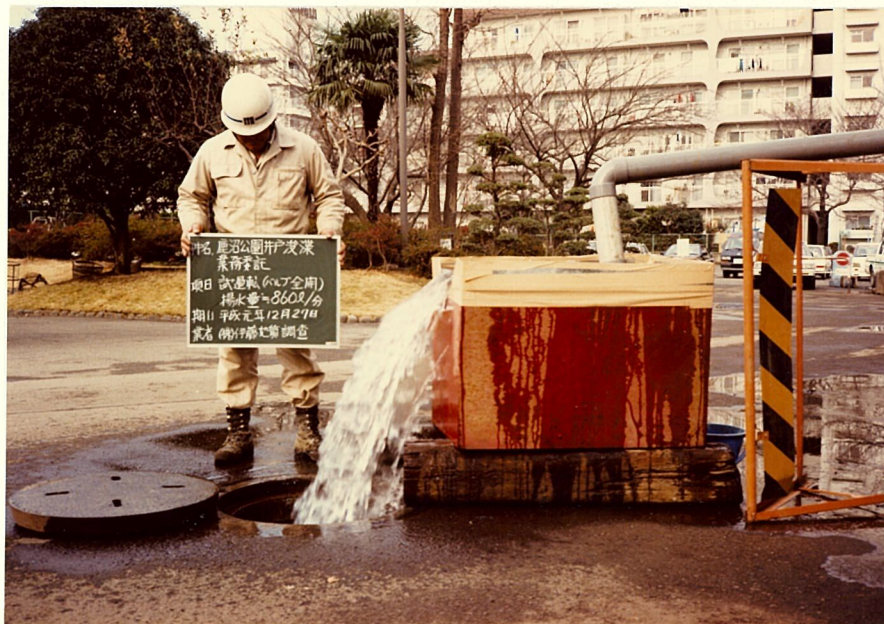
試運転状況 (バルブ全開)
