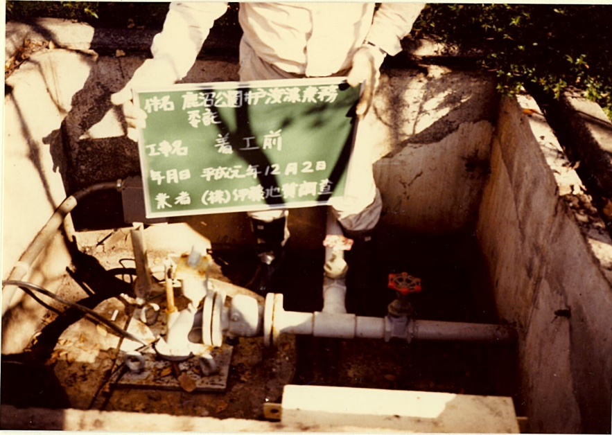
着工前 (井戸枠内)
