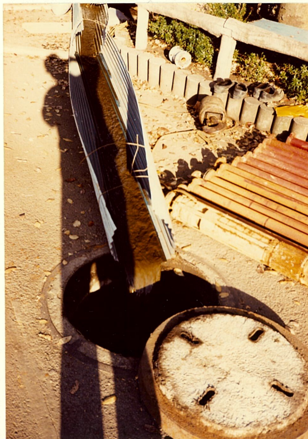
井内洗浄後の汚泥水
