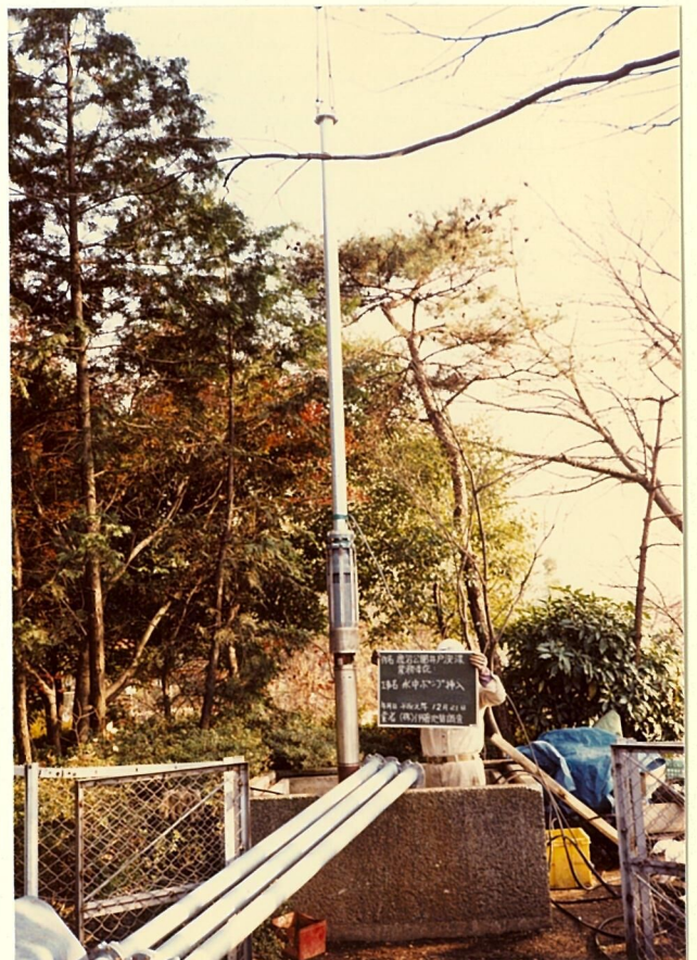
水中ポンプ挿入状況
