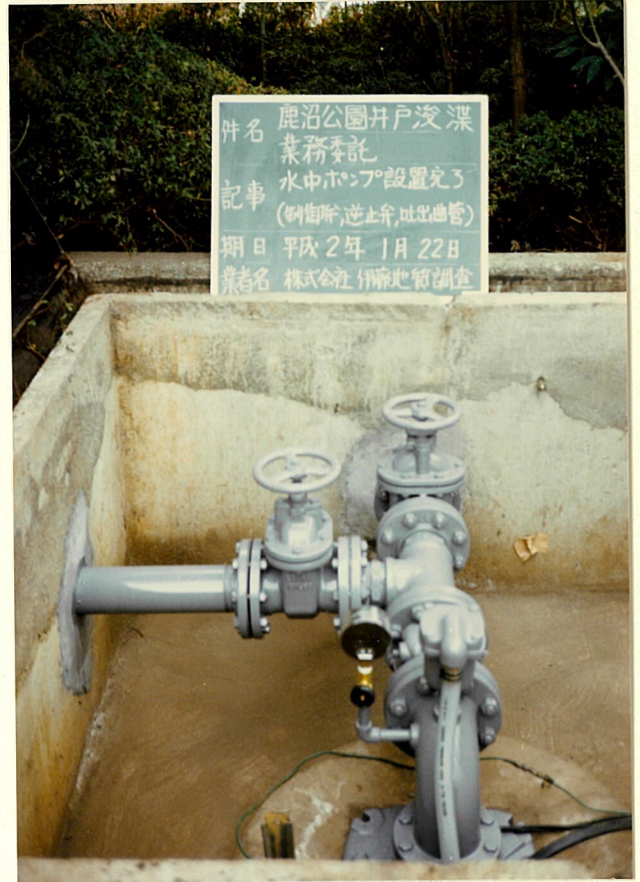
水中ポンプ設置完了
