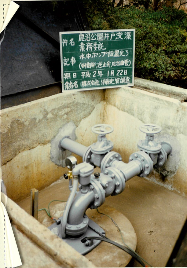
水中ポンプ設置完了
