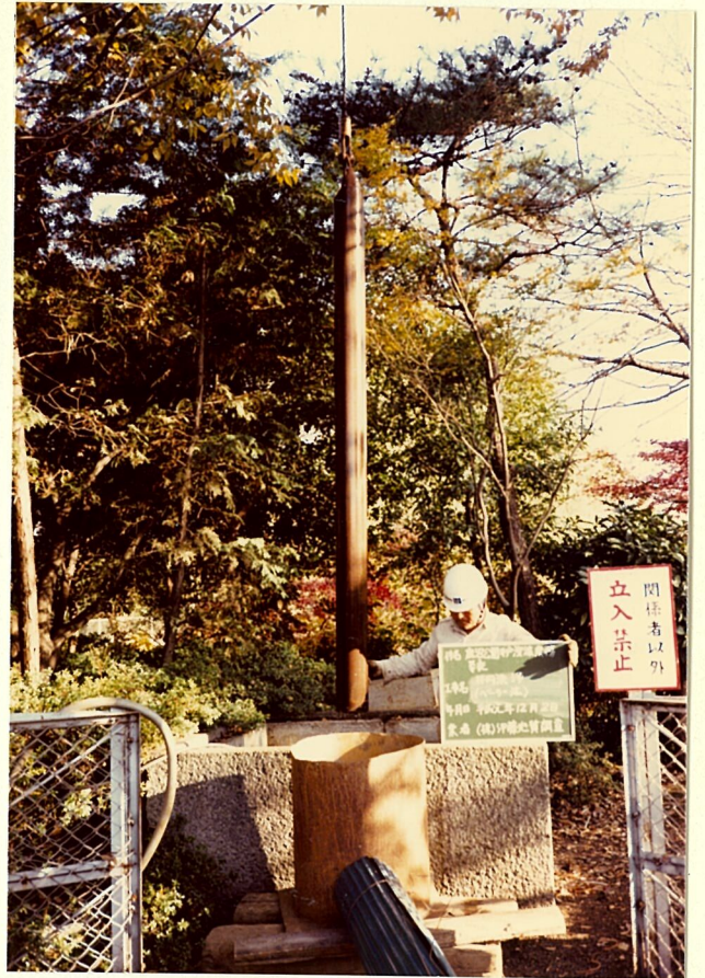
泥水汲揚状況 (バーラー法)
