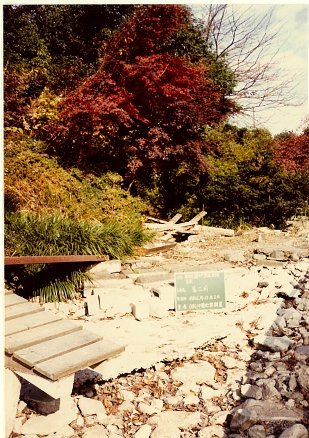
着工前 (放水路)
