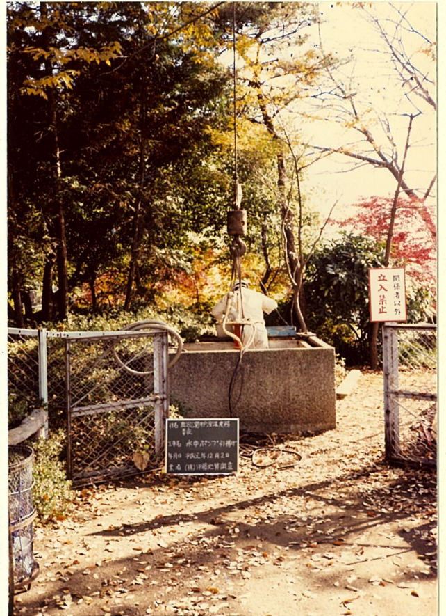
水中ポンプ引揚状況
