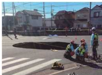
写真：道路陥没の事例
