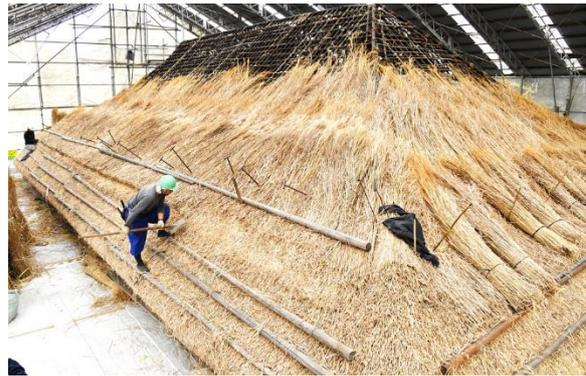
図 4-3 旧青柳庫裏の屋根葺き替え修理
