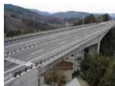
主要幹線道路竣工写真
