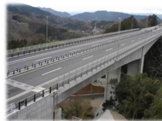
▲主要幹線道路竣工写真
