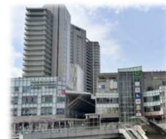
▲相模大野駅北西側の再開発ビル
