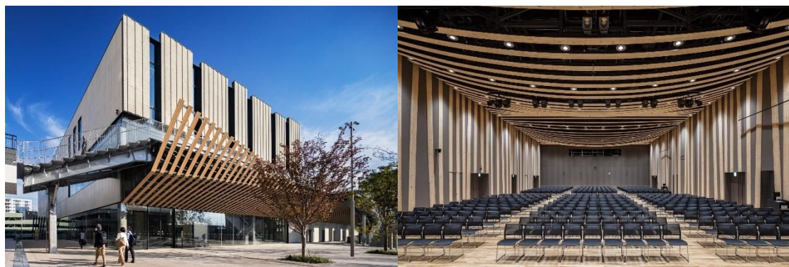
写真左、広場の図：ライトキューブ宇都宮公式 HP, https://light-cube.jp/ 写真下：隈研吾建築都市設計事務所
