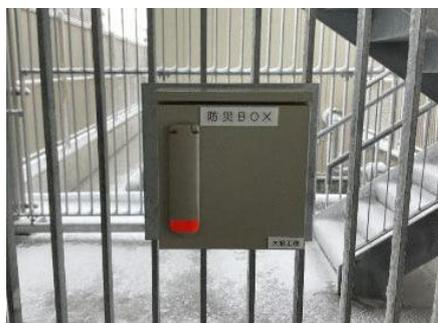
震度5強クラスの地震が発生した場合は、揺れを感知して自動解錠するキーボックスが設置されており、時間外でも円滑な避難ができる。
