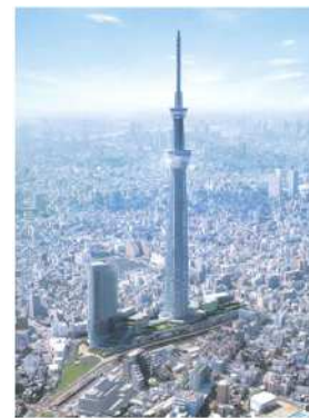
< 地中熱利用導入事例：東京スカイツリー >
