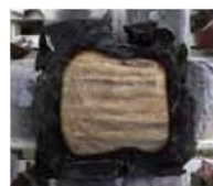
燃焼後の太い柱
