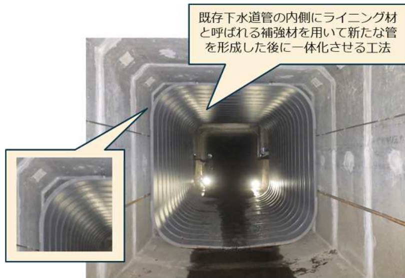
作業途中の製管状態（事故後）
