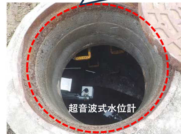
【機器設置状況】
