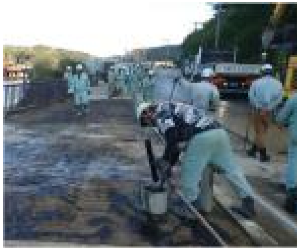
陥没した歩道の仮復旧状況
