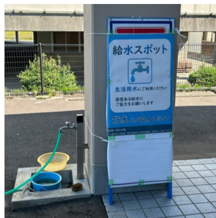
【給水スポットの設置】
