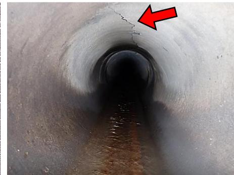
管頂部に軸方向クラックが確認される。
