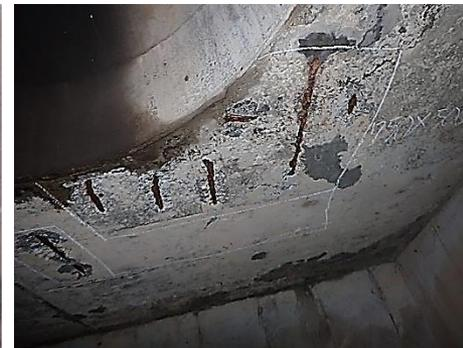
コンクリートの劣化とともに、内部の鉄筋が露出
