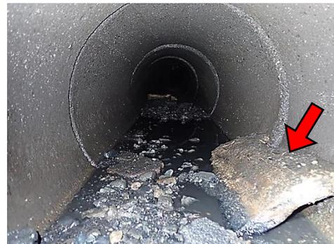
管内に土砂とともに、大きな瓦礫が堆積
