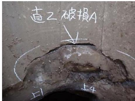
直壁の一部が破損し、コンクリートが大きく剥離
