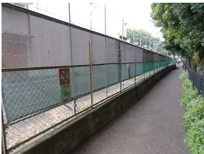
① 仮囲い設置状況
