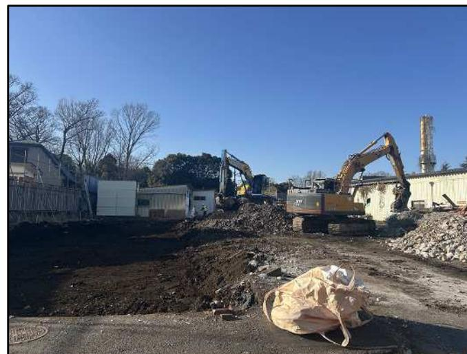
解体工事で発生した廃材は、コンクリート片、金属くずなど品目ごとに分別し、処理施設へ搬出します。
