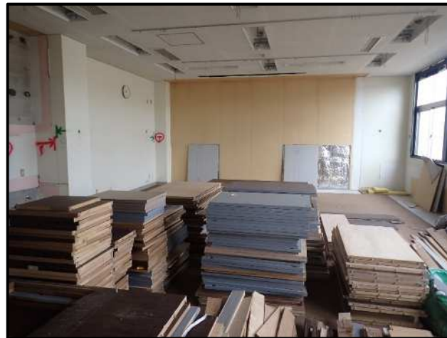
解体材集積状況
