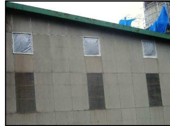
建物を利用した隔離養生の例
