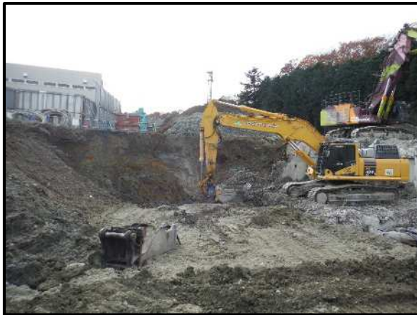
地下部分の解体状況
