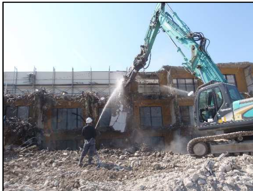
建物の解体状況
