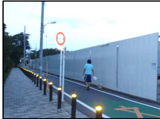
仮囲い設置時のイメージ (3m鉄板製)
