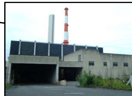
平成25年:王禅寺処理センター (川崎市)
