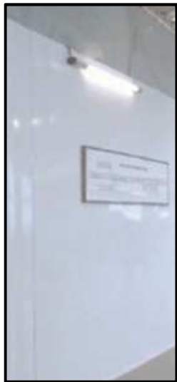
仮設照明の設置例
