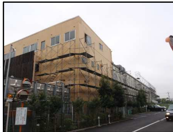
足場組立て中
