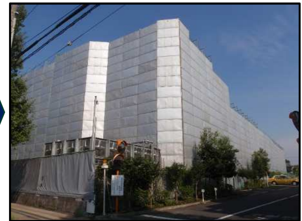
囲い(防音パネル)設置後
