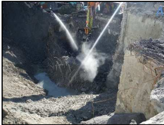
地下部分の解体状況
