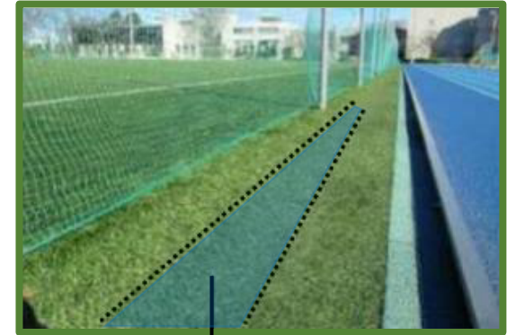
③ 下部は側溝
