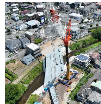
(都) 宮上横山線 橋梁工事
