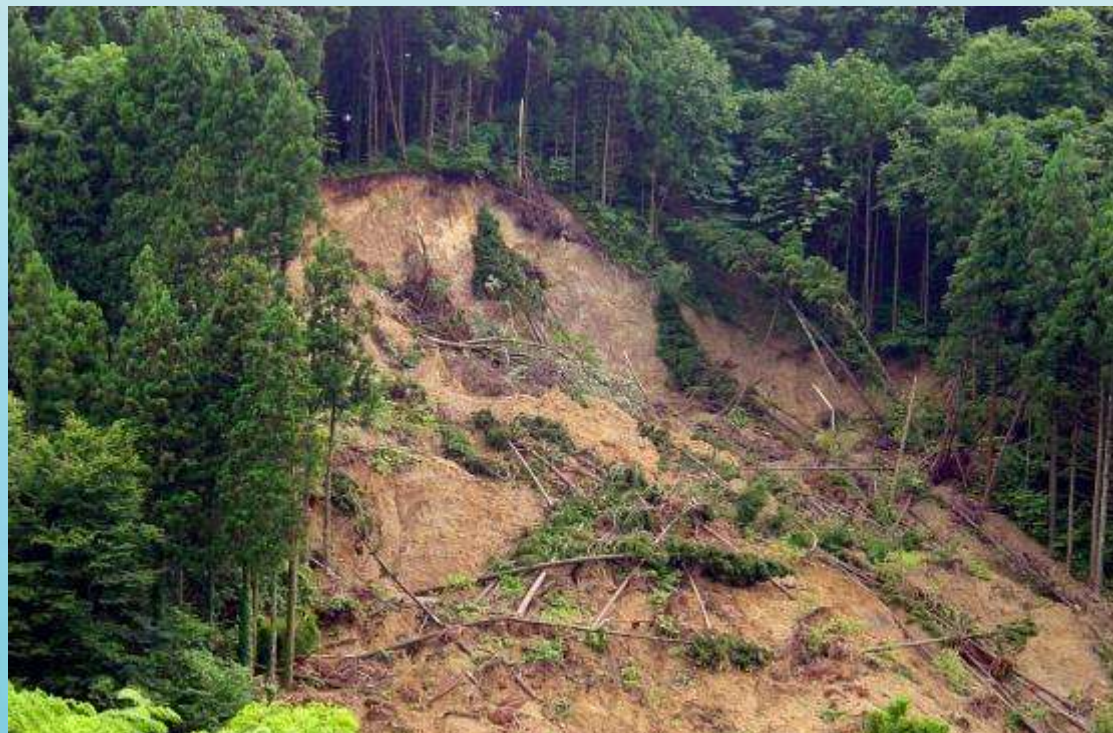
斜面崩壊のイメージ
