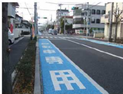
図-7 街渠をエプロン幅の狭い平坦性の高いものに置き換えた事例
