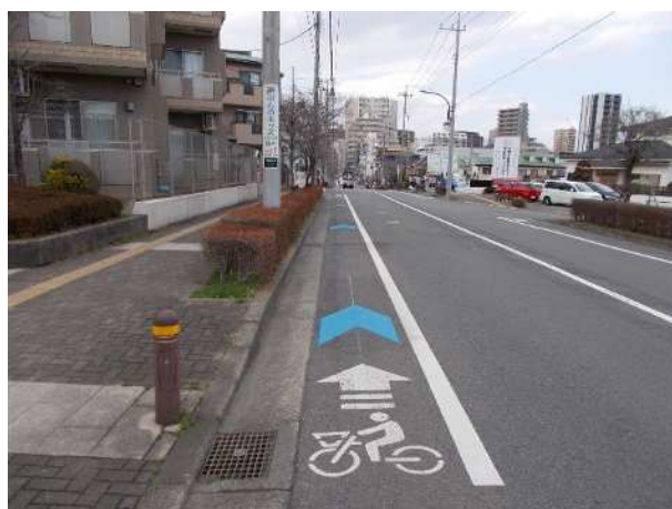
▲車道混在の整備
