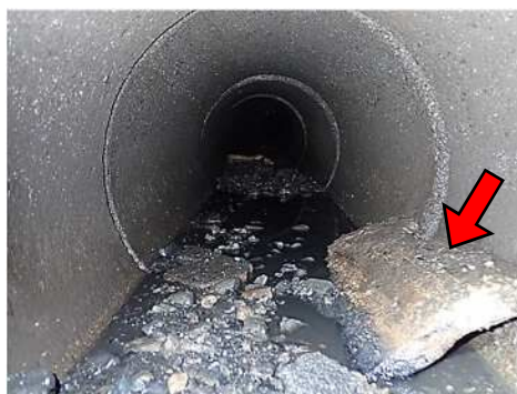
管内に土砂とともに、大きな瓦礫が堆積
