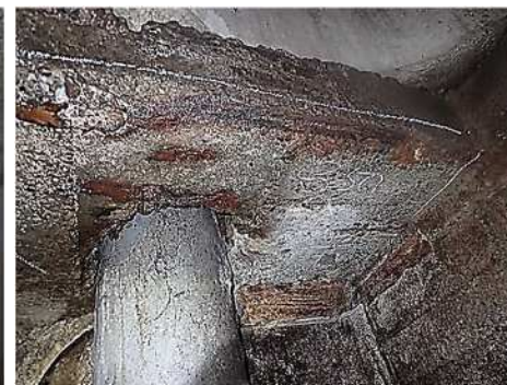
コンクリート内部の鉄筋が露出し、錆が発生
