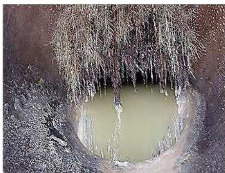
木根が管内に侵入し、流下を阻害する恐れ
