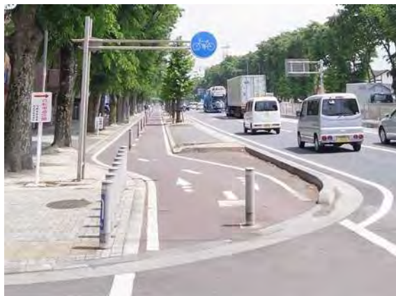
自転車道の設置例(国道16号)
