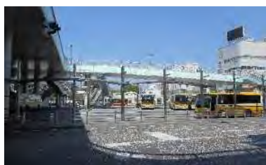
現状の南口バスロータリー
