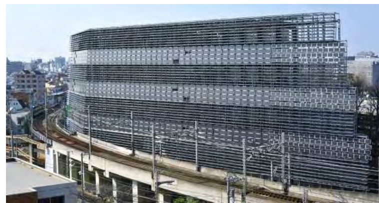
建築壁面に太陽光パネルが取り付けられた例 (写真：東京工業大学環境エネルギーイノベーション棟)
