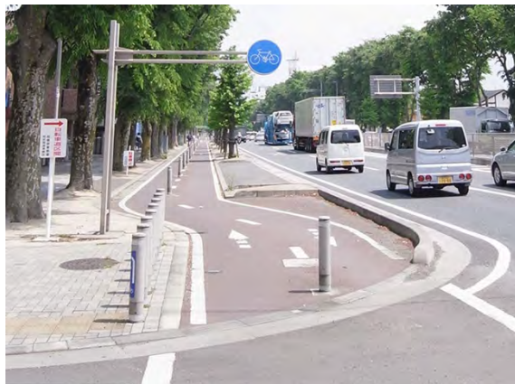
自転車道の設置例(国道16号)
