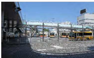
現状の南口バスロータリー
