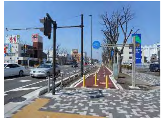
自転車道の設置例（国道16号）
