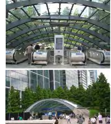
緑の中の地下鉄出入口の例 :カナリーワーフ駅(ロンドン)
