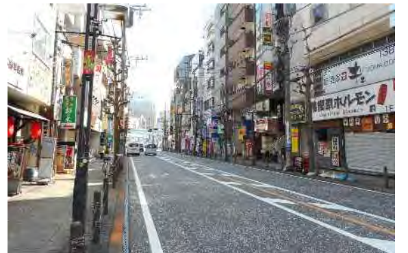
水川通り[電柱地中化整備中](現況)
