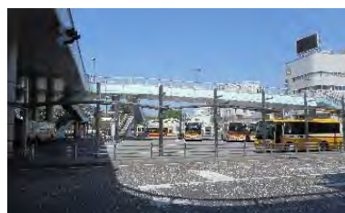
現状の南口バスロータリー
