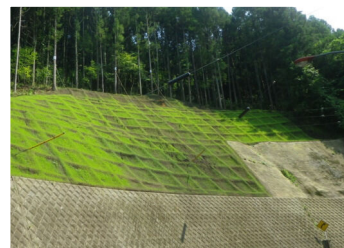
【急傾斜地崩壊対策】
