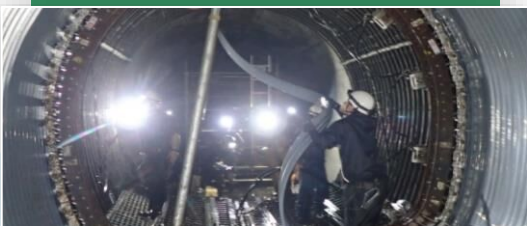
【下水道施設の整備・改築・更新工事】
