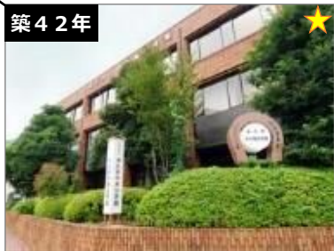
津久井中央公民館・ 津久井老人福祉センター 建築年度：S55 延床面積：2,557㎡
