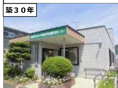
津久井障害者地域活動 支援センター 建築年度：H5 延床面積：230㎡
