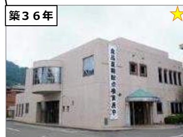
津久井保健センター 建築年度：S62 延床面積：941㎡
