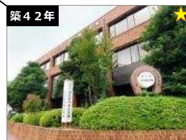
津久井中央公民館・ 津久井老人福祉センター 建築年度：S55 延床面積：2,557㎡
