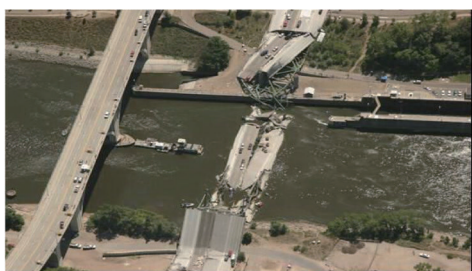
写真1 橋梁崩落事故の状況
