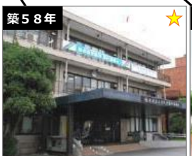
築58年 ★ 津久井総合事務所 建築年度：S39-H18 延床面積：2,434㎡
