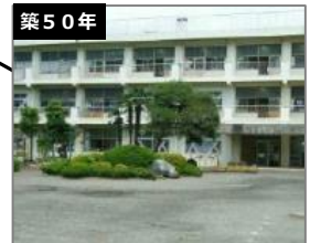
築50年 中野小学校 建築年度：S47-H23 延床面積：6,813㎡
