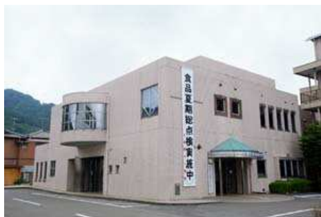
3 津久井保健センター 建築年度S62 延床面積941㎡
