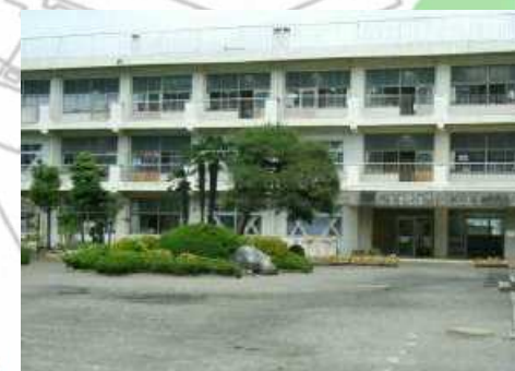
1 中野小学校 建築年度S47-H23 延床面積6,813㎡
