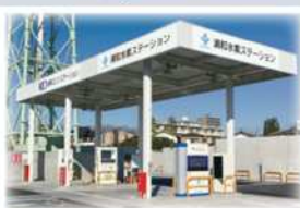
水素ステーション
