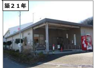
津久井地域福祉センター 建築年度：H12 延床面積：236㎡
