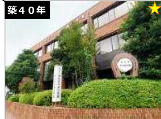
津久井中央公民館・津久井老人福祉センター 建築年度：S56 延床面積：2,546㎡
