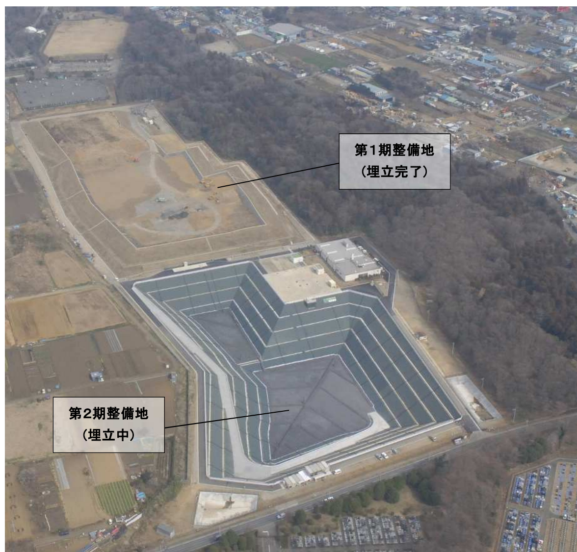
相模原市一般廃棄物最終処分場(平成 20 年 3 月撮影) (第 1 期整備地は最終覆土工事中、第 2 期整備地は竣工直後)
