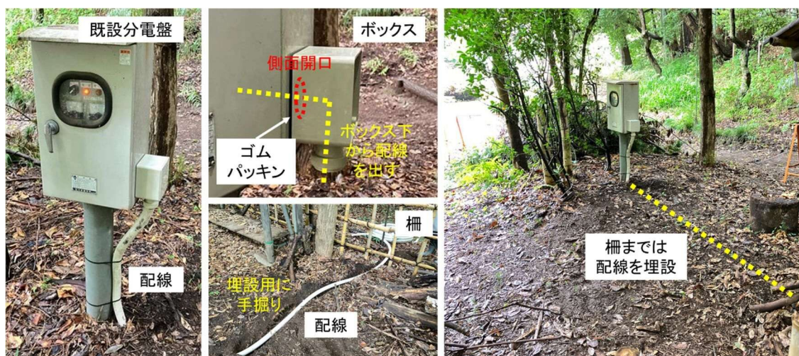
図2-9 既設電源ユニットの開口と配線
