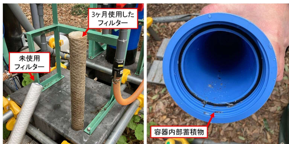
図 3－5 前置フィルター交換状況
