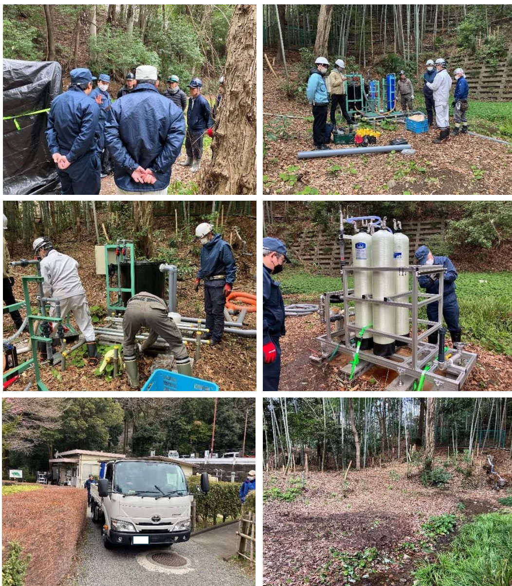
図5－1 撤去作業の様子および撤去後の状況
