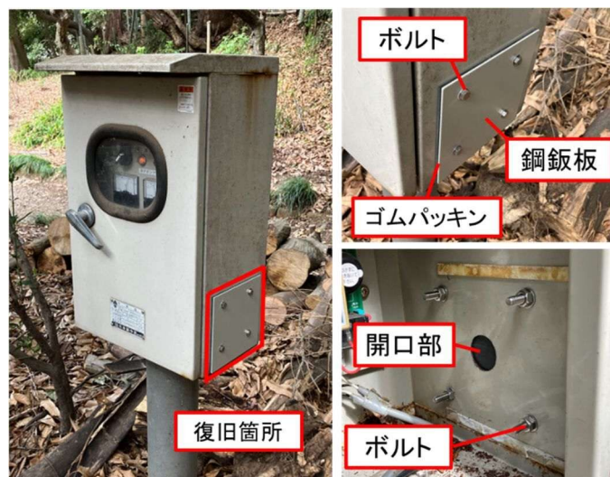
図5-2 既設分電盤の開口部の復旧状況
