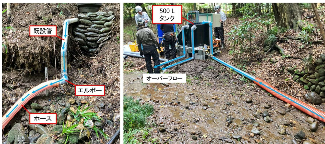
図 2－1 0 既設配管の延長および貯水タンク設置状況
