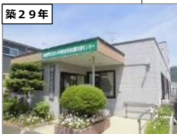
築29年 津久井障害者地域活動 支援センター 建築年度：H5 延床面積：230㎡
