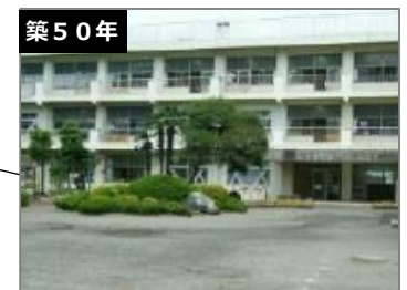
築50年 中野小学校 建築年度：S47-H23 延床面積：6,813㎡
