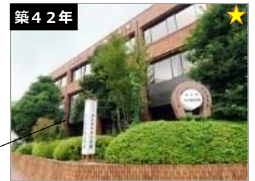
築42年 ★ 津久井中央公民館・ 津久井老人福祉センター 建築年度：S55 延床面積：2,557㎡
