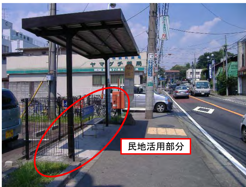
図 5.22 民地を活用したバス待ちスペース（事例：相模原市 久保沢バス停）
