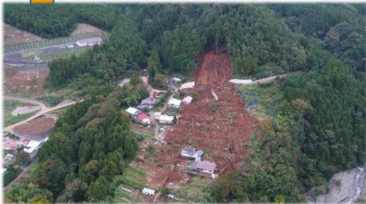
【令和元年東日本台風における土砂災害】
