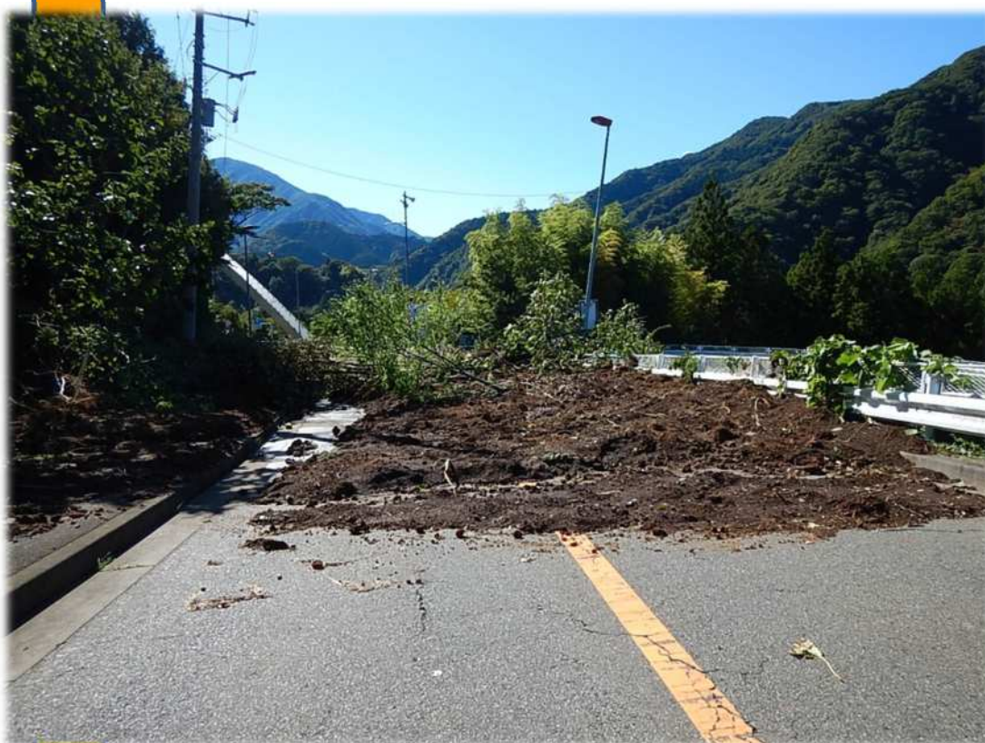
【国道413号での土砂災害】
