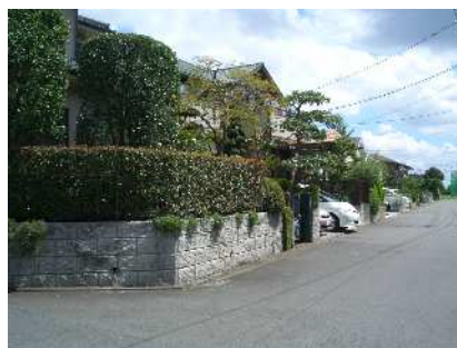
土地区画整理事業により整備された住宅地
